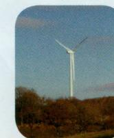
Une éolienne a principalement trois pâles, un axe horizontal qui entraîne une turbine, le tout niché sur un mât. C'est une machine qui utilise l'énergie du vent pour pomper l'eau ou fabriquer de l'électricité. On les place sur une
